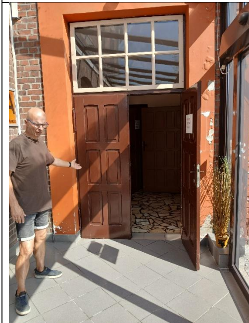
drzwi z naświetłem do wymiany na nowe
