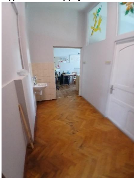
widok korytarza nr 2 z drzwiami do wymiany
