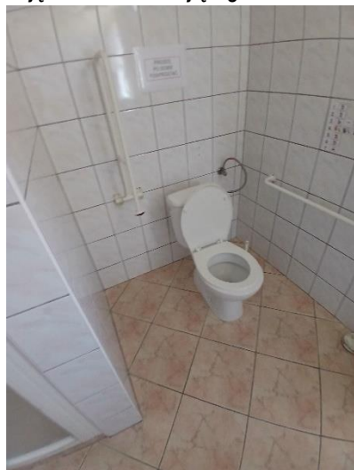
widok łazienki istniejącej
